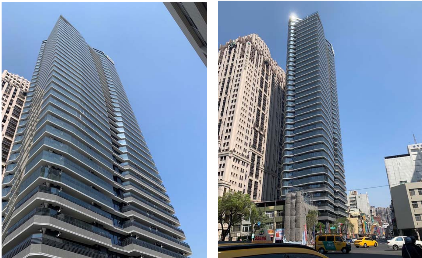
照片 1.1-1 基地現況
