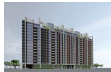
■ 桃園青溪段外觀透視(施工中)
