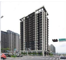
■ 板橋江翠段(施工中)
